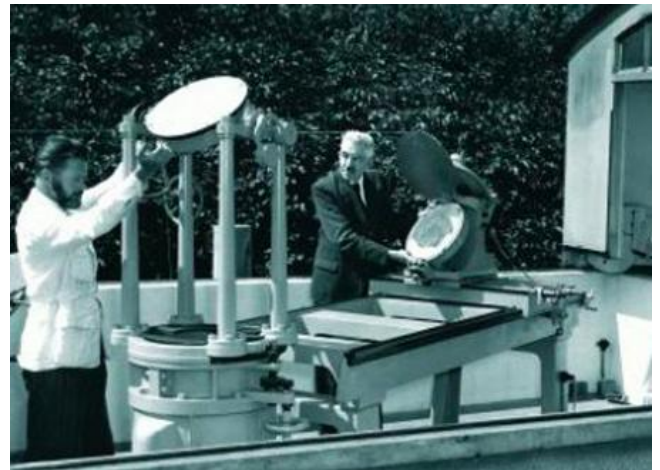
De spiegels die het zonlicht in de zonnetelescoop weerkaatsen
